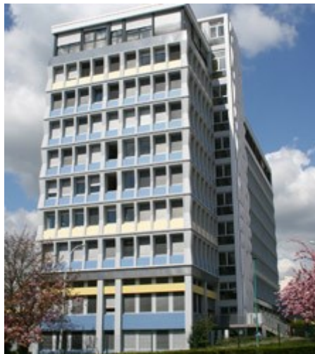
Figure 1 : Facade de la Carsat Centre Ouest
