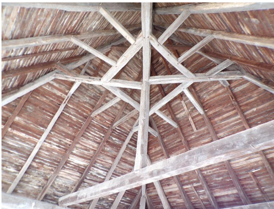
Figure 57 - Détail de la charpente de la Halle de Thémines DELPECH Enzo, 2021
