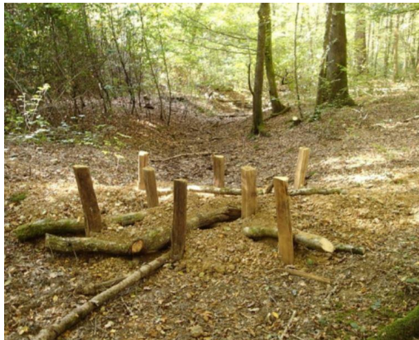
Figure 29: Principe d'ancrage et d'enfouissement des embâcles artificiels
