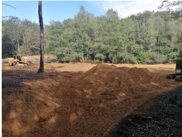
Figure 24 : Exemple pour l'étang du Saujet. Les cailloutis sont pris à moins de 100m des travaux.
