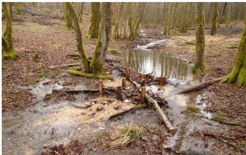
Figure 30 : Rehaussement de la ligne d'eau et réhumidification des franges humides
