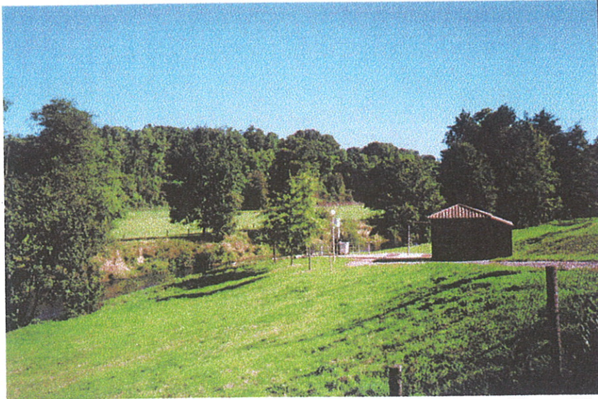
Prise d'eau brute de l'usine d'alimentation en eau potable au Vigen.
