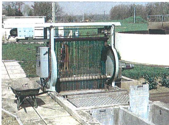
Figure II : Exemple d'un dégrilleur.
