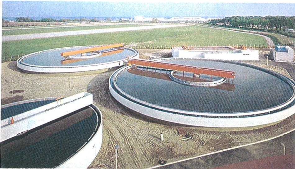
Figure VI : Décanteur - flocculateur (installation de Cannes).
